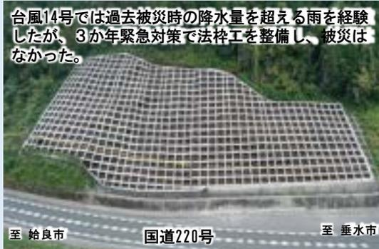
台風14号では過去被災時の降水量を超える雨を経験したが、3か年緊急対策で法砕工を整備し、被災はなかった。
